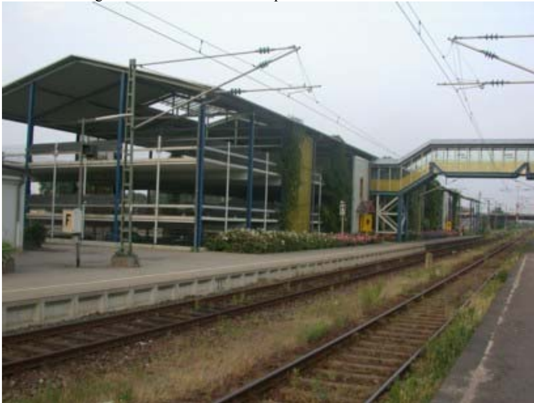
Figure 7 . Exemple unique de parc relais de taille conséquente associé au réseau de Karlsruhe : en gare de WÖRTH. Vue de la passerelle d'accès direct aux voies.
