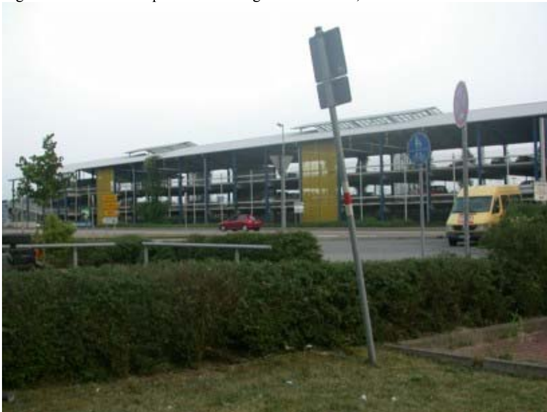
Figure 8. Autre vue du parc relais à étages de WÖRTH, cette fois du côté de l'accès routier.
