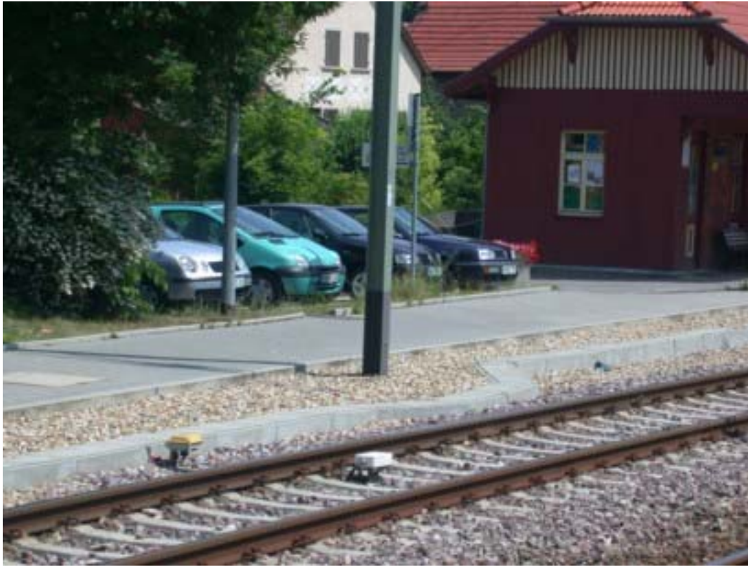
Figure 1. Petite station de tram-train à « Leingarten Mitte » avec quatre places de stationnement voiture. A noter que cette même localité de Leingarten est desservie par trois autres arrêts : Ost, Bahnhof et West
