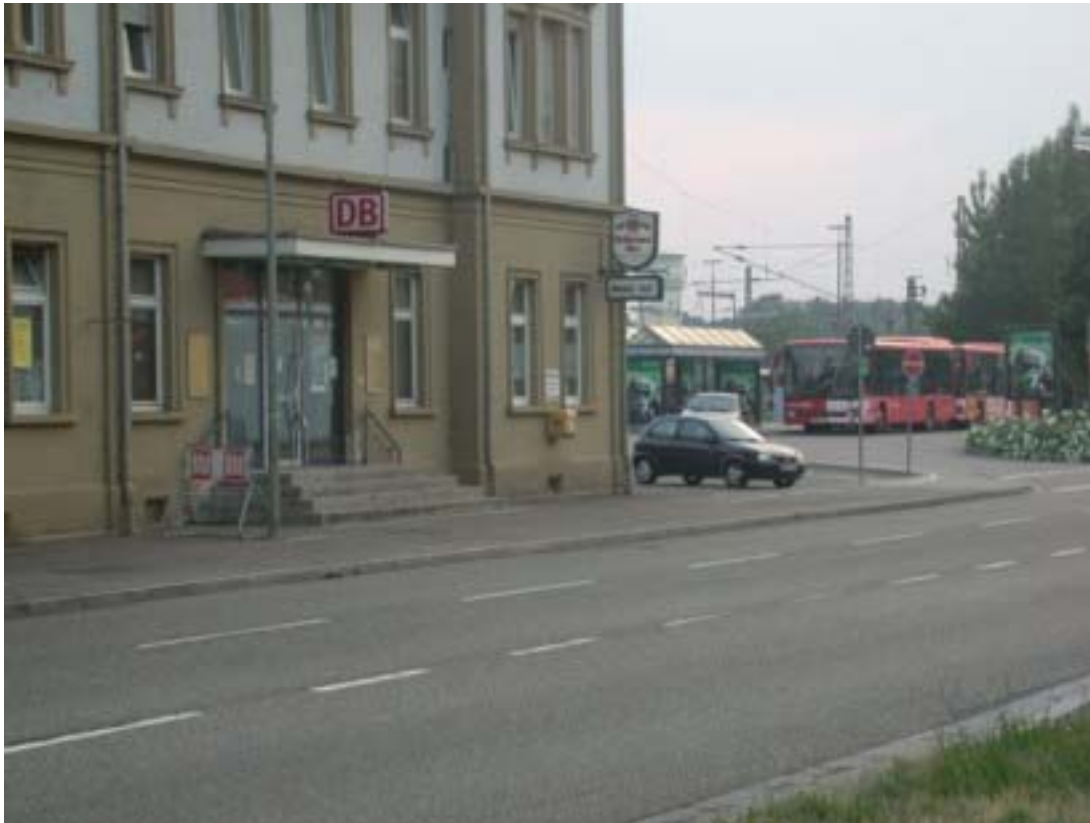
Figure 11. Entrée de la gare de WÖRTH côté accès routier, inter modalité tram-train/bus à droite.
