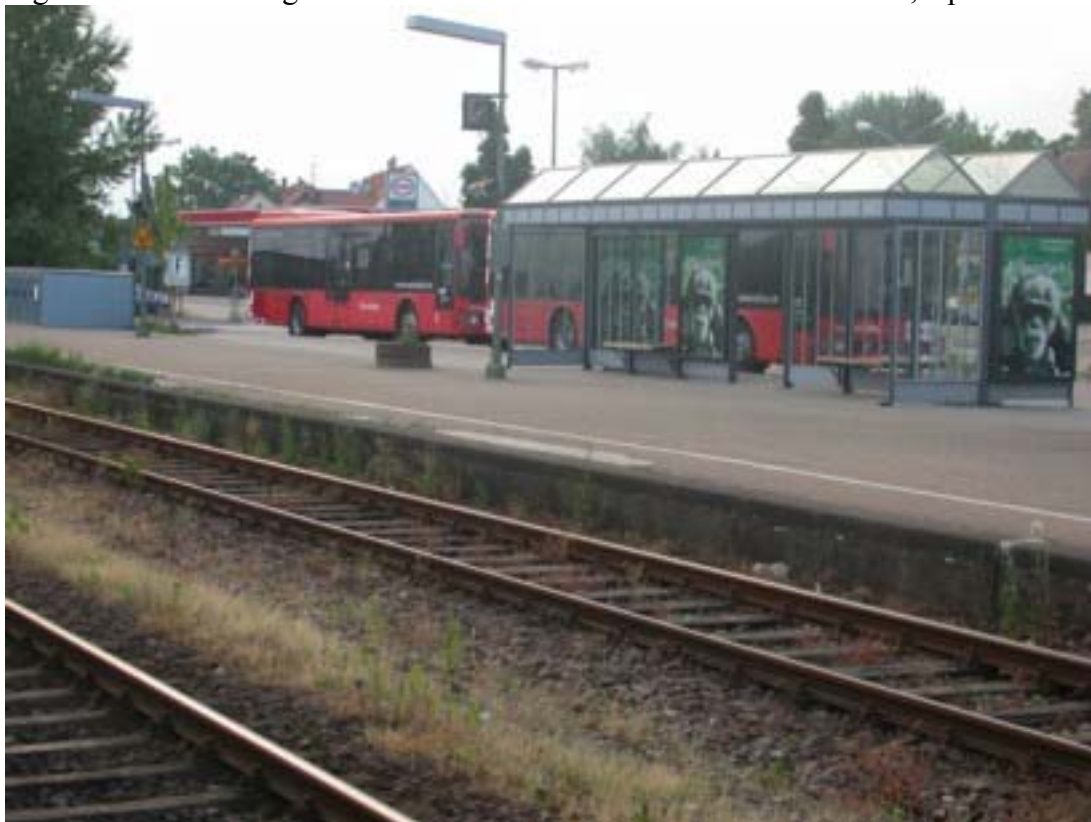
Figure 10. Encore en gare de WÖRTH : inter modalité tram-train / bus, à proximité des voies.
