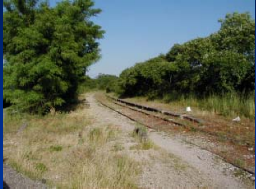
photo de l'ancienne voie du CFEL
